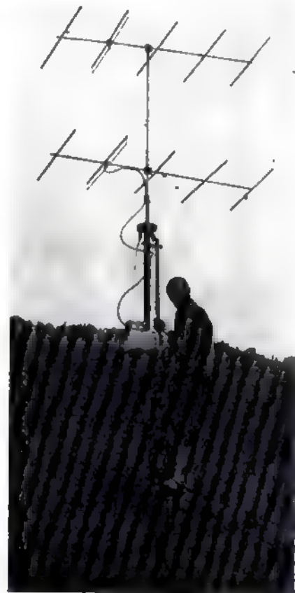
Rys. 2. SP5IB instaluje antenę Yagi
