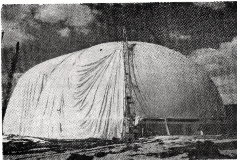
Plastikowa osłona anteny różkowej podczas montażu. Grubość powłoki około 1,6 mm
