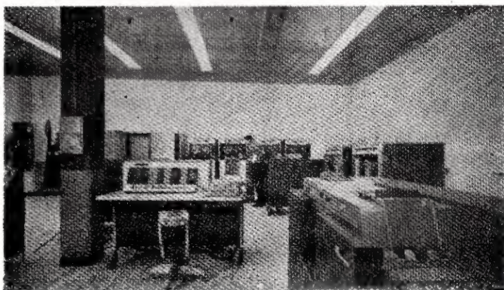
Pomieszczenie aparatury kontrolnej
