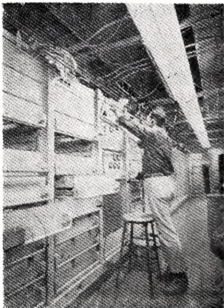
W domku pod anteną znajduje się aparatura wzmacniająca i kontrolna
